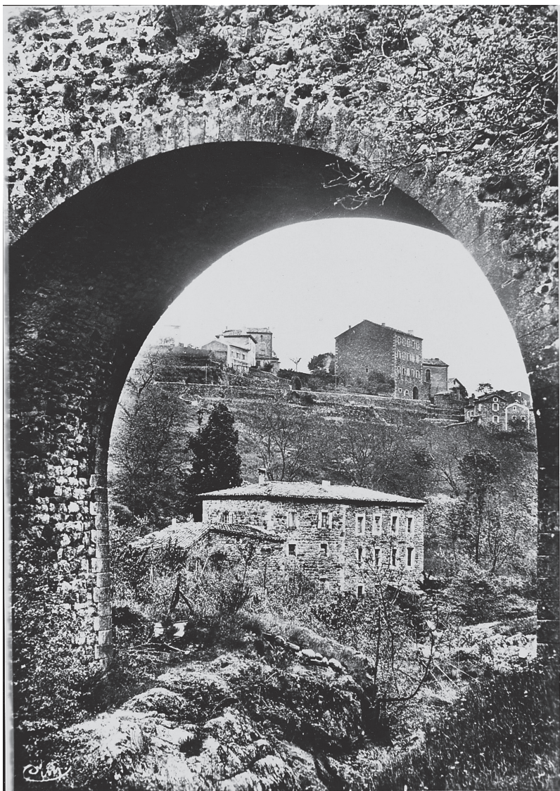
Les bâtiments anciens de la filature
